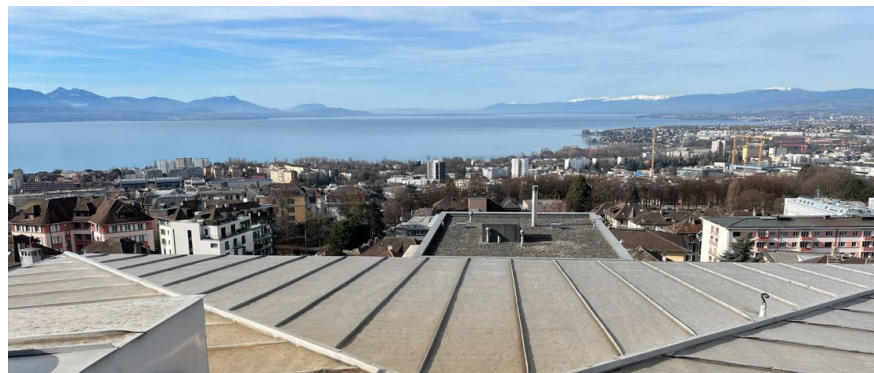
Vue de la future terrasse
