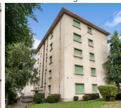
LAUSANNE (VD) Avenue des Bergières 59
