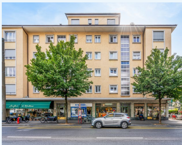
Avenue de Montchoisi 26, 28, Lausanne (VD)
