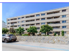
Neuchâtel (NE) Rue de Grise-Pierre 26, 28
