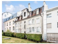
Lausanne (VD) Avenue de France 20
