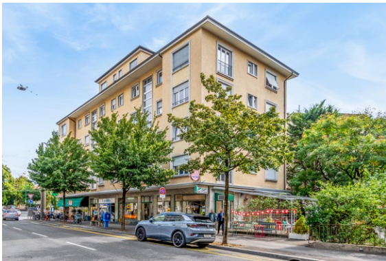
Immeuble existant Bestehendes Gebäude
