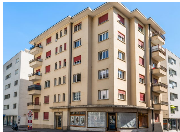
Immeuble existant Bestandsgebäude
