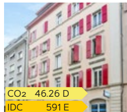
LAUSANNE (VD) Avenue de France 18bis
