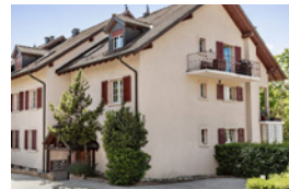
Commugny (VD) Route de l'Eglise 7a, 7b
