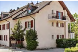
Commugny (VD) Route de l'Eglise 7a, 7b
