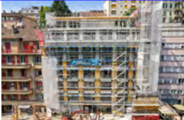
Lausanne (VD) Rue de la Borde 17
