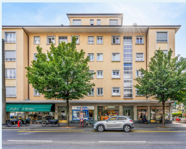
Avenue de Montchoisi 26, 28, Lausanne (VD)
