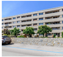
NEUCHÂTEL (NE) Rue de Grise-Pierre 26, 28
