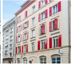
LAUSANNE (VD) Avenue de France 18bis
