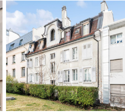
LAUSANNE (VD) Avenue de France 20
