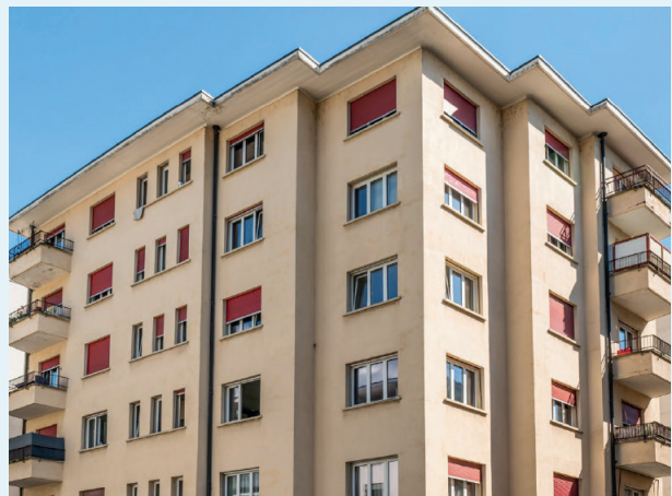
Immeuble existant Bestehendes Gebäude
