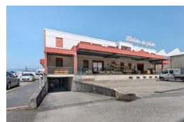
Bussigny (VD) Rue de l'Arc-en-Ciel 8
