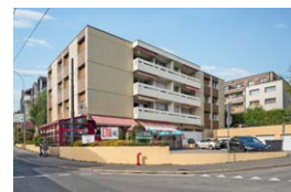
Pully (VD) Chemin des Roches 1
