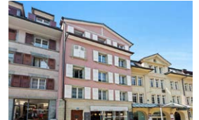
Lausanne (VD) Rue de la Mercerie 14, 16, 18, 20
