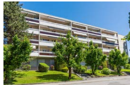
Chavannes-près-Renens (VD) Route de la Maladière 22, 24
