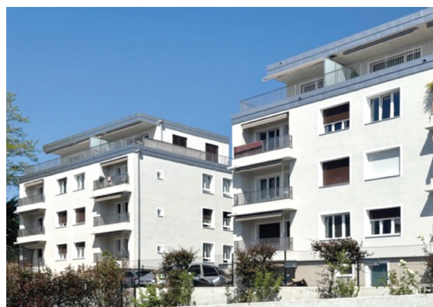
Immeubles situés au Chemin du Ruisselet 18-20-22, à Pully, avant/après l'achèvement des rénovations énergétiques et de surélévation.
