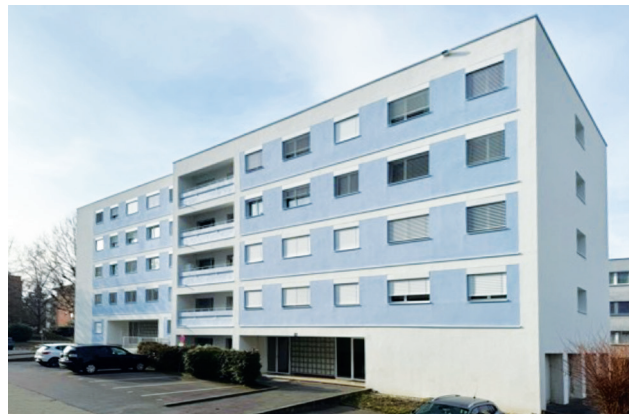
Immeuble situé au Chemin du Caudray 32-34-36, à Renens, avant/après l'achèvement des rénovations énergétiques.
